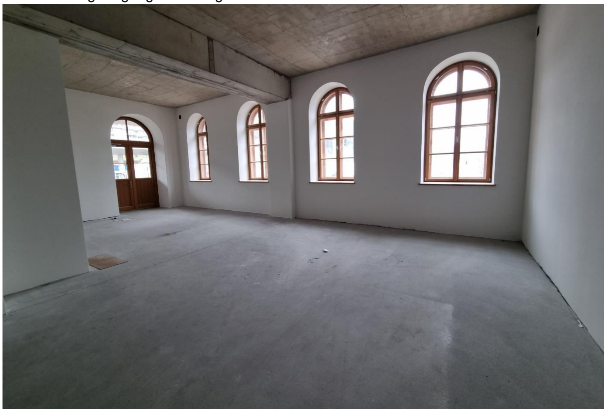
Blick Richtung Eingang Bahnsteigseite
