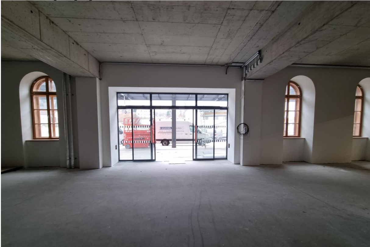
Blick Richtung Eingang Busbahnhof
